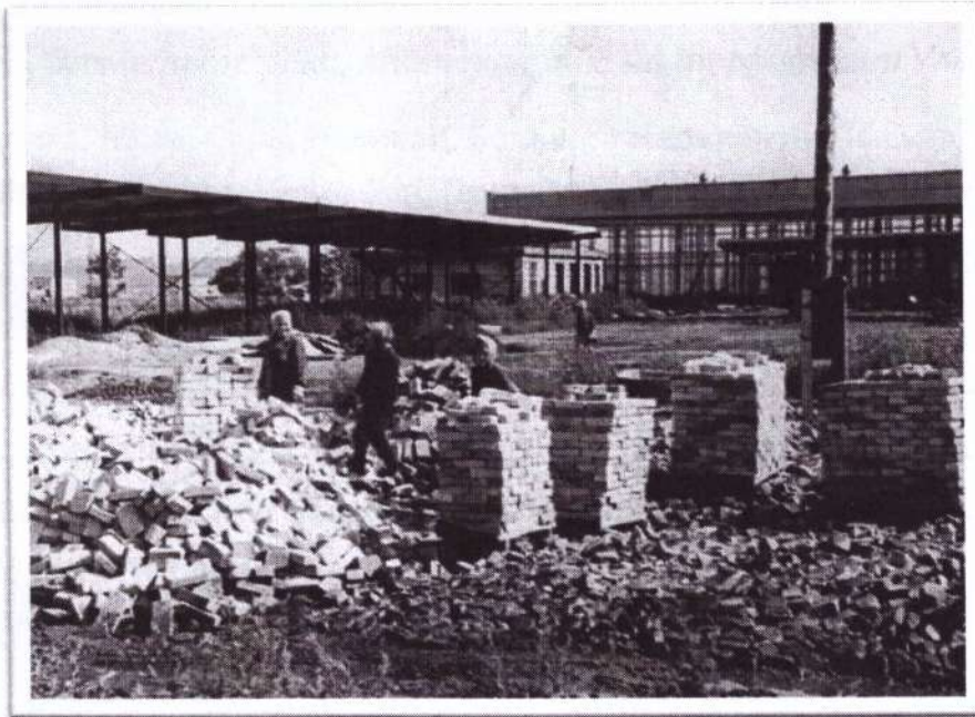
Д. строительство автовокзала
